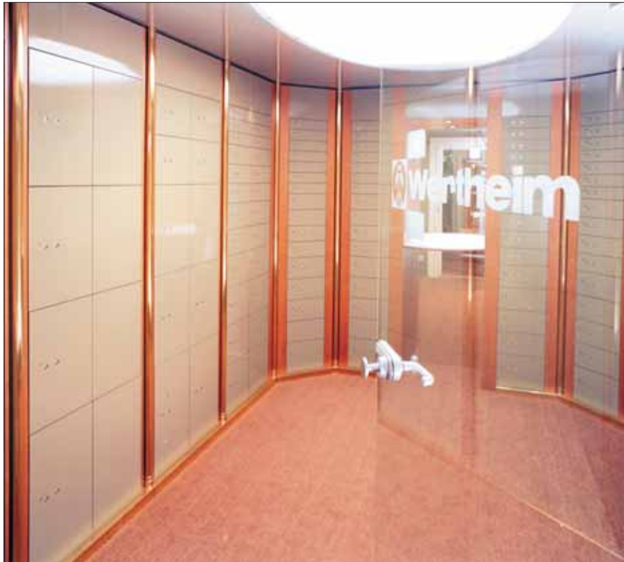
Elektronisch gesteuerte Kundenmietfachanlage in einem Wertschutzraum EET 070
