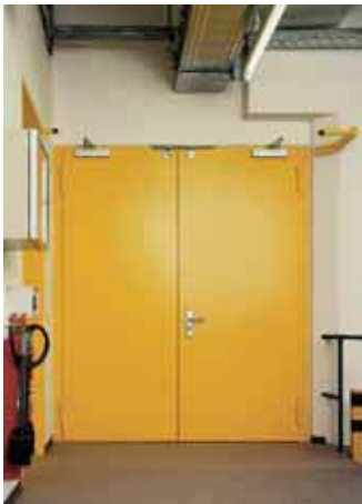
Zweiflügelige Sicherheitstüren O·S·T®-1.2 zum Schutz von Technikräumen neben Brandschutz-Türen B·S·T® und doppelwandigen Industrie-Türen D·I·T. Abbildungen teilweise mit Sonderausstattungen.
