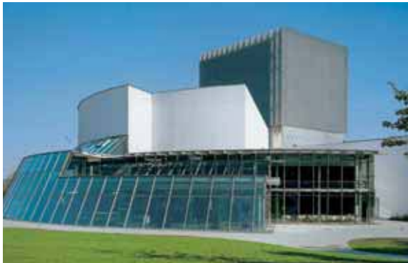
Stahl-Glasfassade, Theater Hof
