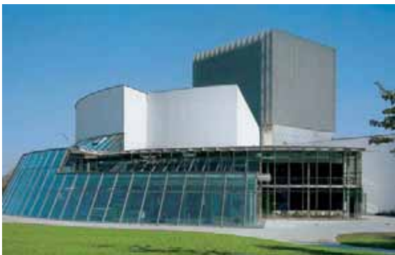
Stahl-Glasfassade, Theater Hof
