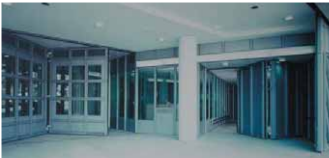
Geldschleuse einer Landeszentralbank
