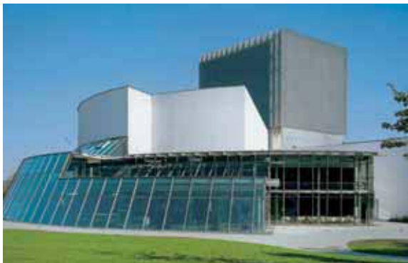
Stahl-Glasfassade, Theater Hof
