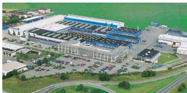
SOMMER – Stammwerk in Döhlau bei Hof/Saale, im Zentrum Europas
